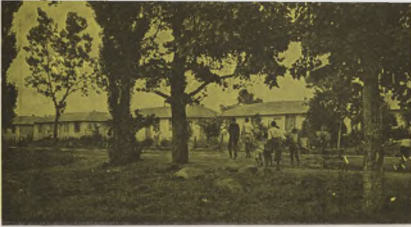
Bome, grasperke en blombeddings verleen reeds 'n lommerryke toegang tot openbare geboue
