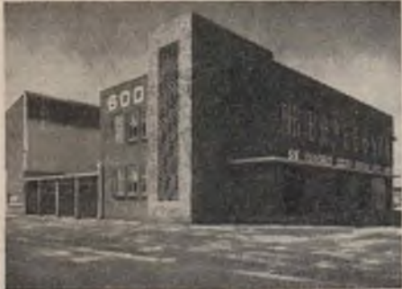
Kantoor en fabriek, Spartan, Kempton Park.
