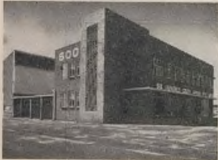
Kantoor en fabriek, Spartan, Kempton Park.
