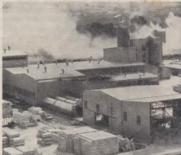
Gebouekompleks vir Hebel-Gasbeton, Roodepoort.
