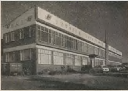
Kantoor en fabriek van staal, steen en beton, Industria – ontwerp en opgerig deur B & G.
