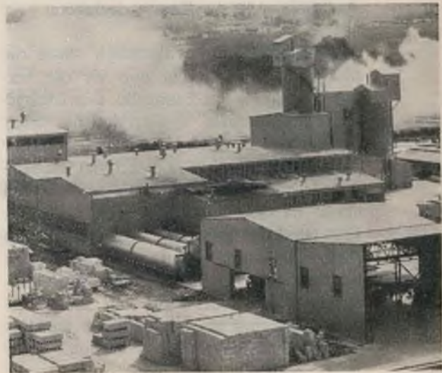
Gebouekompleks vir Hebel-Gasbeton, Roodepoort.
