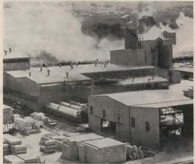
Gebouekompleks vir Hebel-Gasbeton, Roodepoort.
