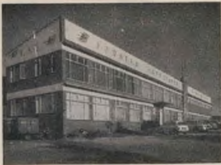
Kantoor en fabriek van staal, steen en beton, Industria - ontwerp en opgerig deur B & G.
